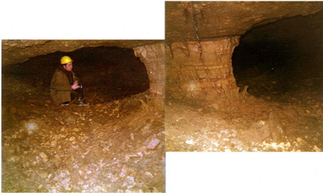
*Diese Fotomontage rechts zeigt sehr anschaulich das Innere der Höhle. In der Mitte befindet sich ein Stützpfiler. Hieraus ist zu ersehen, daß ein unterirdischer Tuffsteinabbau erfolgte. Darunter rechts zum Vergleich: Römerbergweg Meurin in Kretz*
